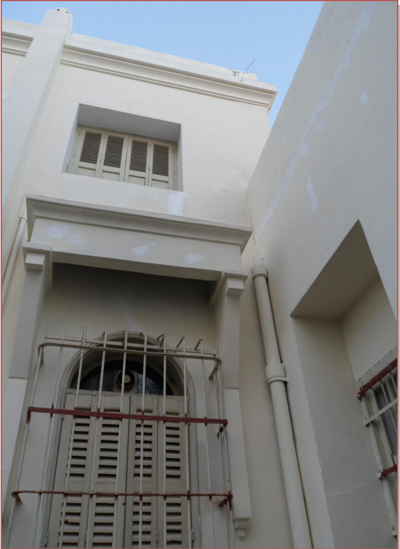
Ancienne porte d'accès de la première église (côté ouest)
